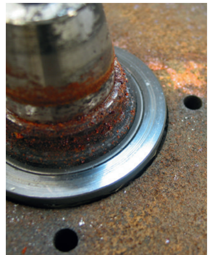
Zerstörte Gleitringdichtung – die Lauffläche wurde von Fremdpartikeln zersetzt
